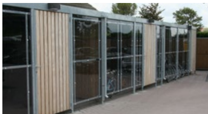
Sidevægge, bagvæg og døre med vertikalt åben træbeklædning samt facadevæg med klar polykarbonat
